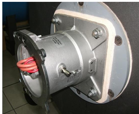
2) Смонтировать Смесительную Группу на котле;
