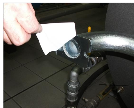
6) Снять заглушку из Труба ГАЗОВОЙ рампы;
