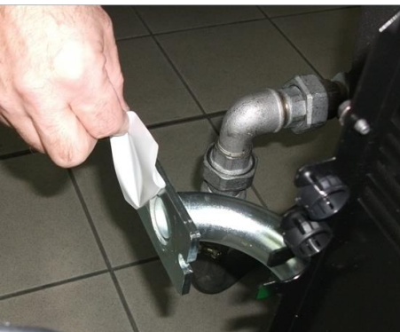
7) Снять заглушку из Труба ГАЗОВОЙ рампы;
